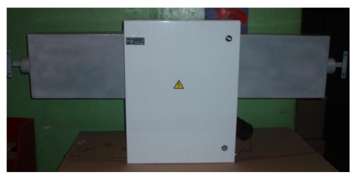
Путейский ящик - устройство для подключение силовых электрических агрегатов большой мощности (до 40 кВт) напряжением 380 Вольт. Установлены вдоль путей с интервалом не более 100 метров. От шлейфа питания путейских ящиков также питаются притоннельные устройства и сооружения (дренажные перекачки, сооружения ГО). Конструкции путейских ящиков отличаются друг от друга, в зависимости от года ввода оборудования в эксплуатацию.
