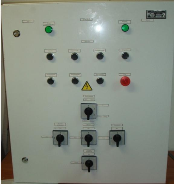
Цифра в наименовании ШУЗ показывает мощность электродвигателя, который может быть подключен к шкафу. Для выбора шкафа управления задвижкой под конкретный электродвигатель необходимо руководствоваться приведенным в таблице 1 значением номинального линейного тока, а не потребляемой расчетной мощностью электродвигателя.
